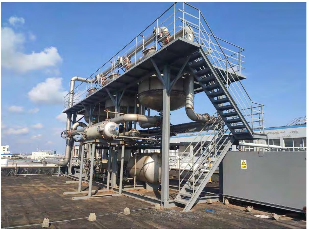
图 4-3-1 废气吸收装置
